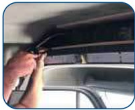
Fuga en evaporador de ambulancia.
